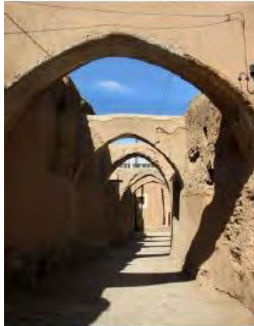
تصویر شماره ۱- سایه‌اندازی در مسیر توسط ساباطها- مأخذ: (کردنژاد، سلیمانی تفتی، ۱۳۹۴)
