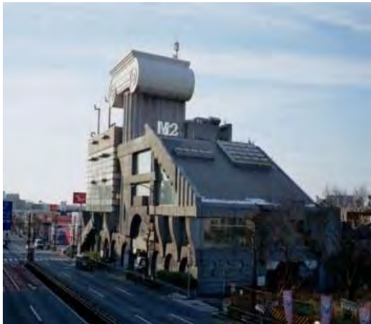
تصویر ۲- ساختمان M2-توکيو- ژاپن. www.kkaa.co.jp
