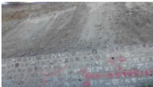
شکل ۱۲: احداث دیواره‌های نگهدارنده کم‌ارتفاع جهت جلوگیری از ناپایداری دامنه‌ای
