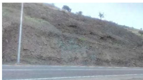
شکل ۱۱: رخنمون رسوبات منفصل و مستعد لغزش در اطراف جاده خلخال - سرچم در امتداد دره کیوی‌چای در نتیجه ایجاد ترانشه
