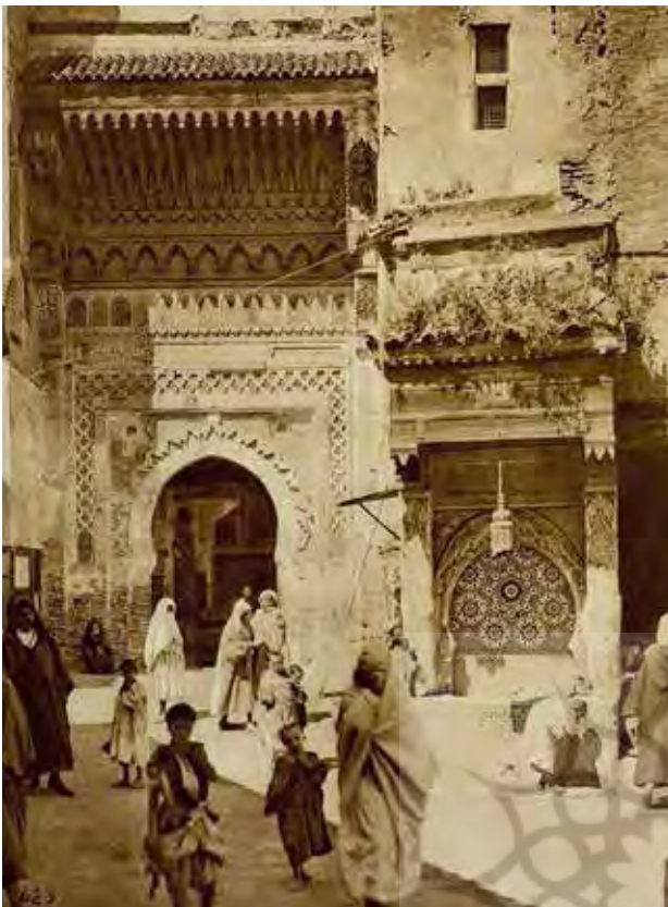
تصویر ۸. کاروانسرای النجاریین در شهر فاس، میدان چه مقابل سردر ورودی و سقایه موجود در این میدانچه. مأخذ: www.cdn.saaih.com
