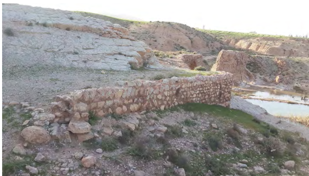
تصویر ۱۶. صفه در سمت جنوب پل که بالاجبار به جهت دور زدن صخره ساخته شده است (نگارندگان، ۱۳۹۶).
