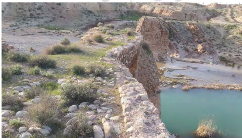
تصویر ۱۲. نمایی از پل کوار. جان پناه‌ها با ملات ساروج ساخته شده است (نگارندگان، ۱۳۹۶).
