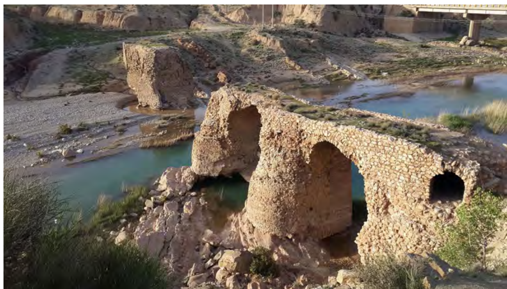
تصویر ۱۰. پل کوار از نمای جنوب غربی و مشرف بر اتاقک نگهدانی جنوبی (نگارندگان، ۱۳۹۶).
