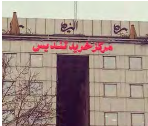
تصویر ۳. ساخت بنا با سبک مدرنیسم در فضای وضع موجود میدان تجریش مأخذ: نگارندگان، ۱۳۹۶.
