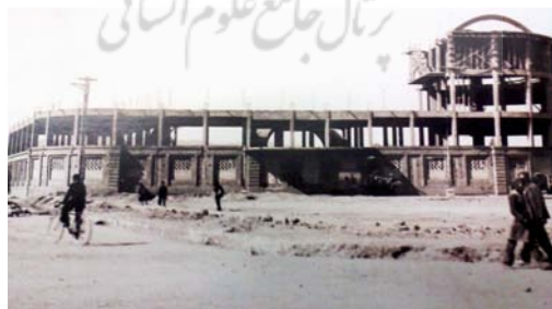
ساختمان شهرداری مشهد در حال ساخت در اواخر دوره رضاشاه
