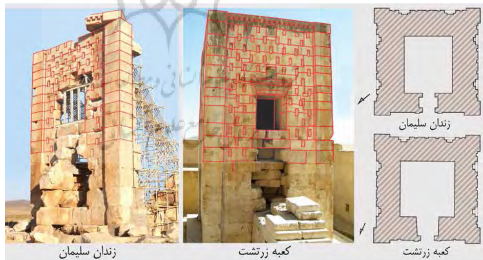
تصویر ۸: کعبه زرتشت و زندان سلیمان. الگوی چیدمان و اتصالات سنگ‌ها، نیز شکل پلان
