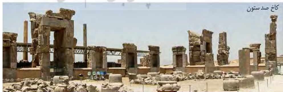
تصویر ۱: عناصر سنگی تشکیل‌دهندهٔ بازشوها در میان دیوارهای خشتی و آجری جای گرفته‌اند.
