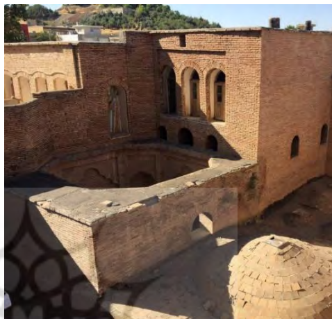
تصویر شماره ۱۲: دید از بالای ساختمان مطبخ
