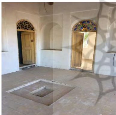
تصویر شماره ۲۳: تزیینات کرسی خانه عمارت
