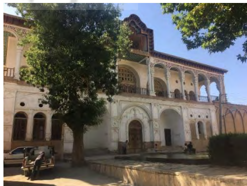
تصویر شماره ۱۴: ایوان های خارجی عمارت
