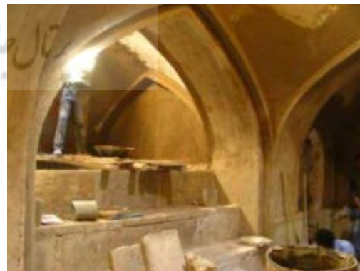
تصویر شماره ۱۱: نمای داخلی حمام عمارت خسرو آباد (مأخذ: زندى، بهرامى، فیضى، نجفى، ۱۳۹۶)
