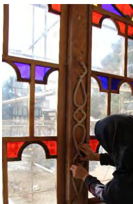
تصویر ۱۸- نصب آلت ها در چهارچوب اصلی
