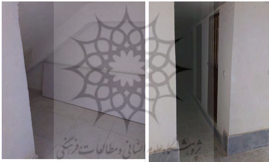
شماره ۴- نمونه ای از انباری های مسکن مهر رشت و راهروی تنگ و تاریک آن. آبان ۹۳ شماره ۵- نمونه ای از زیرپله های مسکن مهر رشت و نقاط کور در آن. آبان ۹۳
