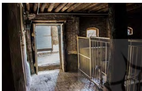
شکل ۱۳ نمای داخلی طبقه همکف مسجد قوله
