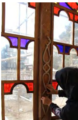
تصویر ۱۸- نصب آلت ها در چهارچوب اصلی
