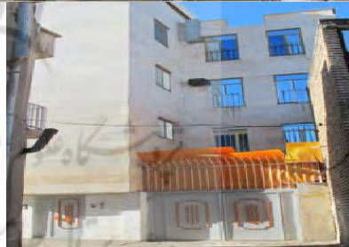
شکل شماره (۶): غیر همگون بودن مصالح بکار رفته در بنا
