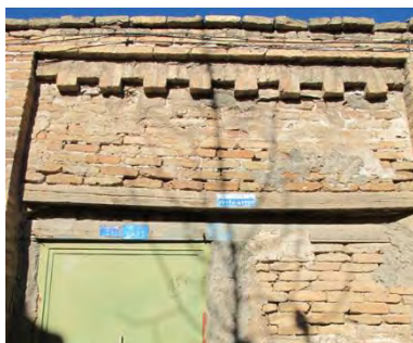
شکل شماره (۷): فرسودگی مصالح و ملات‌ها
