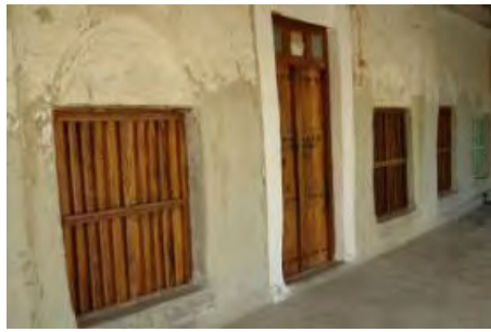
شکل ۶- جزئیات بازشوهای چوبی (منبع: میراث فرهنگی)
