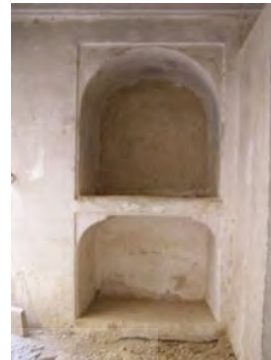
شکل ۱- ایجاد طاقچه های دیواری- خانه موجود خواجه بیدختی (میراث فرهنگی گناباد)
