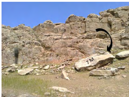
شکل ۵. وفور درزه‌های افقی، عمودی، و متقاطع در یک پرتگاه با ارتفاع تقریباً ۲۰ متری در لایه‌های سنگی سازند آغاچاری. این عامل سبب جداسدن قطعه سنگی با طول ۷ متر (با فلش از نقطه‌ای که جدا شده نشان داده شده است) از دیواره صخره شده است که بر اثر حرکت واریزه‌ای از نوع چرخشی رخ داده است
