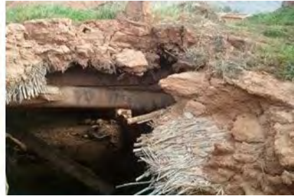
تصویر شماره (۵). نمایی از اجزای بام خانه‌ای با معماری سنتی در هلسم
