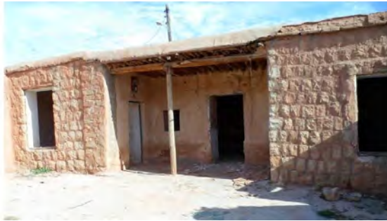
تصویر شماره (۲). بنای ایوان‌دار در حال تخریب
