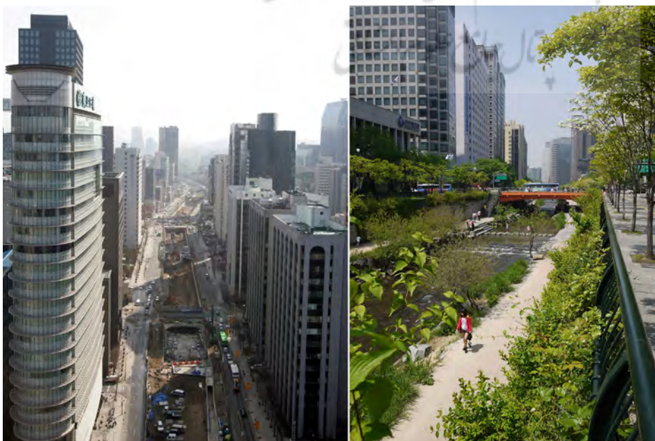
تصویر ۱ : رودخانه جوانگی چوان، سئول، کره جنوبی، حین ساماندهی و پس از احیاء. مأخذ : http://www.citylab.com/commute/2014/04/tearing-down-urban-highway-can-give-rise-whole-new-city/8924/
