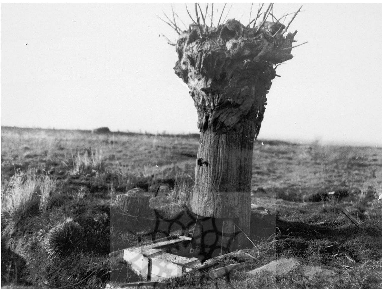
تصویر ۶: یک درخت مصنوعی که به‌عنوان پست دیدبانی گمراه‌کننده استفاده شد. عکس‌ها و طرح‌های درختان موجود در میدان جنگ به یک کارگاه فرستاده شد و در آنجا هنرمندان درختان مصنوعی را با استفاده از استوانه‌های فلزی توخالی ساختند که سپس به‌عنوان درختان جاسوسی در میدان جنگ به کار رفتند. مأخذ: http://historywars.tumblr.com/image/113093075934JPG .
