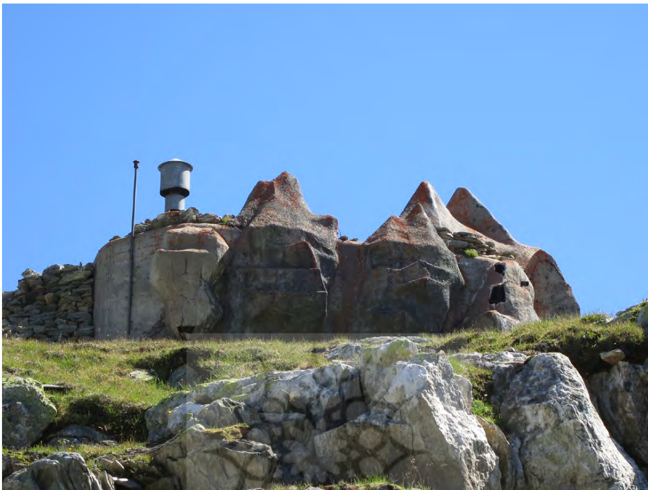
تصویر ۷: سوئیس توسط ساختارهای پنهان و جعلی سازه‌های نظامی به یک معما تبدیل شده است. چیزی که به نظر یک تخته‌سنگ می‌رسد، در حقیقت انبار مهمات است که از آهن و بتن ساخته شده و به شکل تخته‌سنگ نقاشی شده است. سنگری در گذرگاه گوتهارد (Gotthard Pass). مأخذ: https://de.wikipedia.org/wiki/Festung_Gütsch#/media/File:Gütsch_MG.JPG
