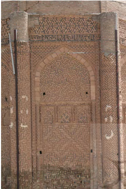
تصویر ۲: ۱. ستون فلکه با نقش «۷ و ۸ گلچین و نیم خفته، راسته»؛ ۲. ازاره پس‌نشین نقش «پیلی خفته، راسته»؛ ۳. مربعی منقوش آجری؛ ۴. نقوش فرفره‌گردان در دور طاق‌ها؛ ۵. قوس لاپوش و پشت بغل؛ ۶ خط کوفی از سوره مبارکه حشر در گرداگرد (برج خرقان قزوین)
