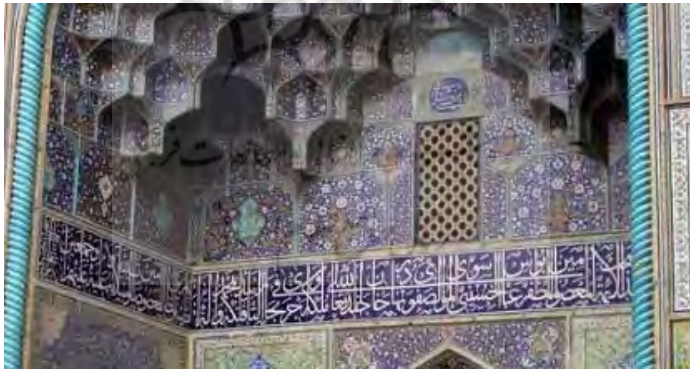
شکل ۱۳. کتیبه ورودی مسجد
