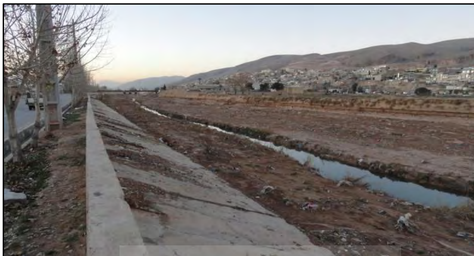
شکل ۵: نمای از رودخانه در پایین تر از پل سردخانه.
