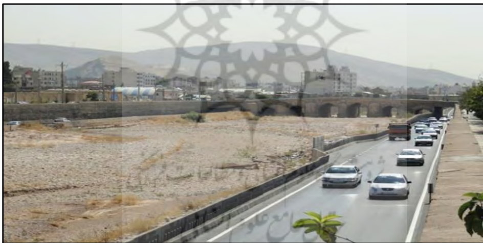
شکل ۲: ابعاد و ارتفاع نامناسب پل‌ها و احداث کنار گذر در بستر رودخانه برای حمل و نقل عمومی .
