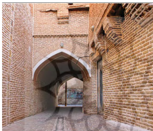
تصویر ۲-۷: تونجه (نمونه‌ای از نحوه افزایش سطح بنا در طبقه اول با استفاده از پیش آمدگی پله‌ای آجر از سمت معبر در بافت دزفول).
