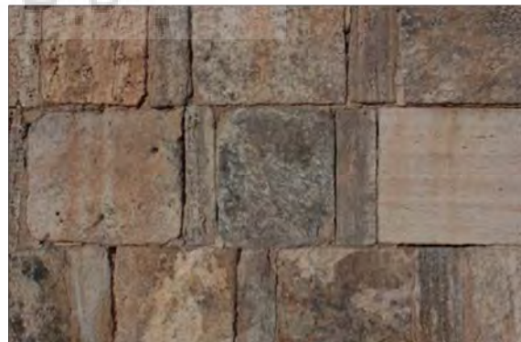
شکل ۱۴: تشکیل پاتین اگزالات با رنگ‌های مختلف بر روی سنگ‌های تراورتن. سمت راست: عمارت هشت‌ضلعی مجموعه‌ی میراث جهانی تخت سلیمان. سمت چپ: بنای موسوم به زندان سلیمان مجموعه‌ی میراث جهانی پاسارگاد (پیرک، پاییز ۱۳۸۹).
