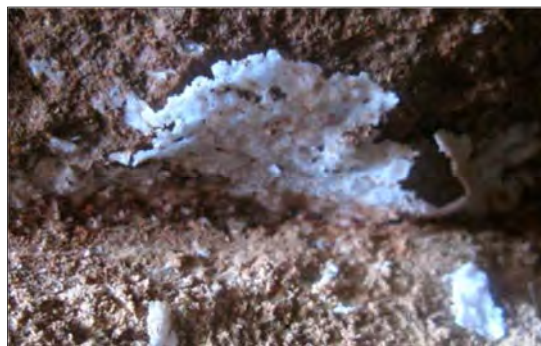
شکل ۵: شوره‌های حاصل از تبلور کلریدها در سطح آجرکاری و تخریب ناشی از آن؛ آرامگاه هفت‌تپه (بیرک، پاییز ۱۳۹۱).
