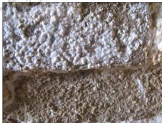
شکل ۳: تشکیل بلورهای سخت سولفات کلسیم هیدراته بر روی مواد و مصالح دیواره‌ی جنوب و جنوب‌غربی آرامگاه هفت‌تپه؛ مجموعه‌ی میراث جهانی چغازنبیل و هفت‌تپه (پیرک، بهار ۱۳۹۰).
