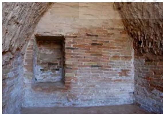
شکل ۳: تشکیل بلورهای سخت سولفات کلسیم هیدراته بر روی مواد و مصالح دیواره‌ی جنوب و جنوب‌غربی آرامگاه هفت‌تپه؛ مجموعه‌ی میراث جهانی چغازنبیل و هفت‌تپه (پیرک، بهار ۱۳۹۰).
