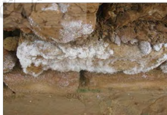
شکل ۴: سمت راست: نفوذ آب حاصل از بارندگی در ساختار دیوار و ظهور شوره‌های سولفات‌ها در سطح آجرکاری. ضلع شمال‌غربی معبد چغازنبیل. سمت چپ: تشکیل شوره‌های سولفات‌ها بر روی مواد و مصالح دیواره‌ی غربی آتشکده‌ی آذرگن‌سبب مجموعه‌ی جهانی تخت سلیمان (پیرک، پاییز ۱۳۹۱).
