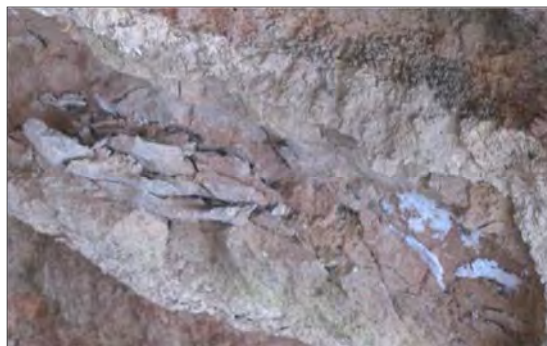
شکل ۵: شوره‌های حاصل از تبلور کلریدها در سطح آجرکاری و تخریب ناشی از آن؛ آرامگاه هفت‌تپه (بیرک، پاییز ۱۳۹۱).
