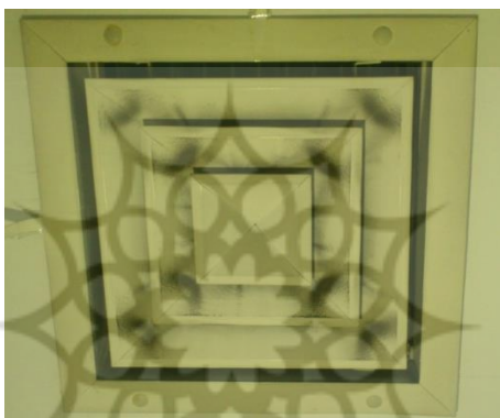
شکل (۵) تصویر دریچه هوای ورودی به اتاق
