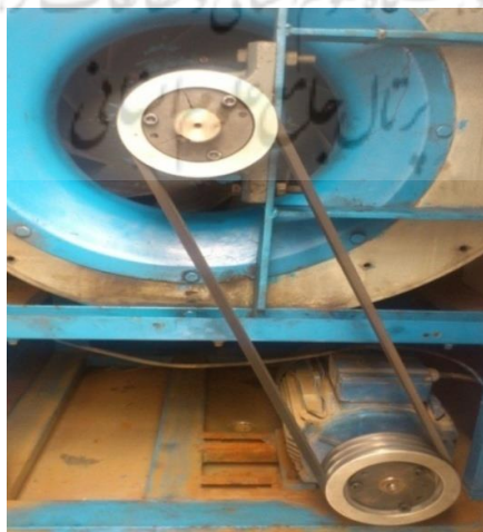
شکل (۴) تصاویر پولی های بلوور و الکتروموتور بعد از اصلاح
