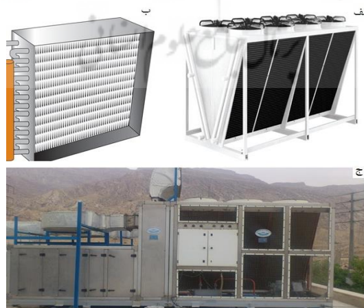
شکل (۲) تصویر سیستم HVAC مورد مطالعه، الف) تصویر کندانسور V-Type، ب) تصویر اوپراتور، ج) نمای کلی پکیج HVAC
