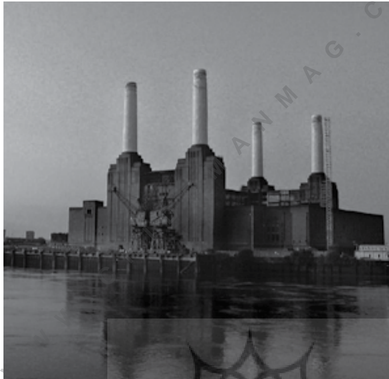
تصویر شماره ۵: نیروگاه برق Battersea، مکان: لندن، انگلستان؛ سال: ۲۰۰۸ (شروع پروژه)؛ طراح: شرکت طراحی Universal
