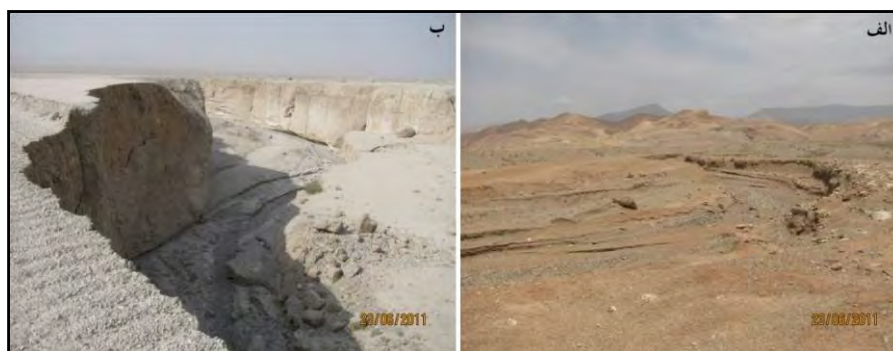
شکل ۱۰: حفر بستر جریان اصلی مخروط‌افکنه شماره ۱۱ (الف) و مخروط شماره ۱۵ (ب)
