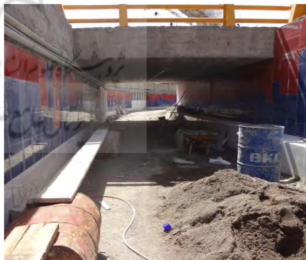
زیرگذر منطقه ۱۱ - بزرگراه میثاق
