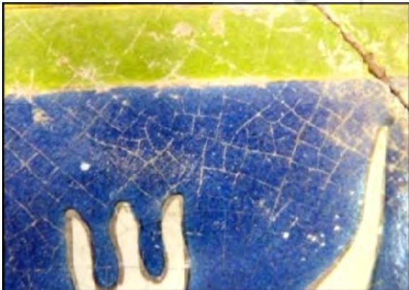
تصویر ۴- شبکه‌ی ترک‌ها در سطح لعاب کاشی تصویر ۵- پدیده‌ی پوسته‌شدن لعاب در حاشیه‌های کاشی
