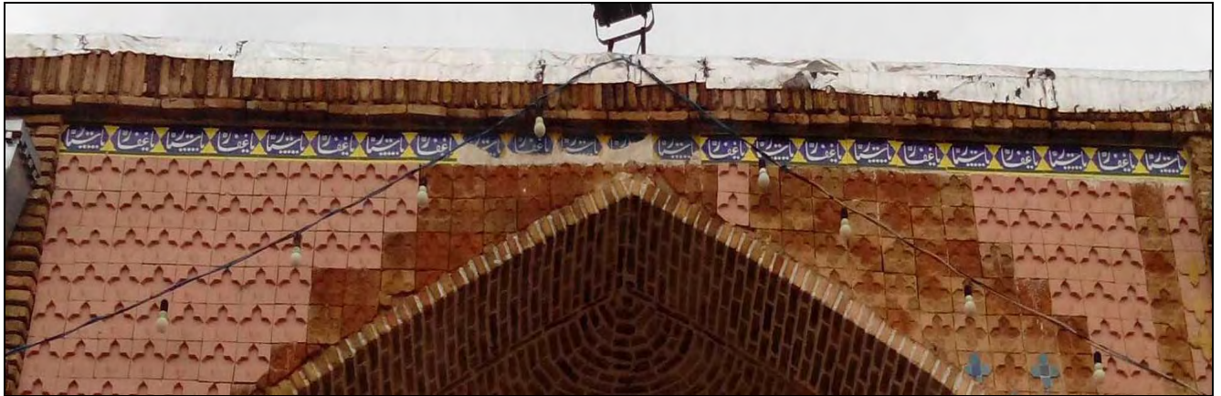
تصویر ۱۲. وضعیت آرایه‌های کاشی پس از نصب و نحوه قرارگیری کاشی‌های تاریخی و جدید
