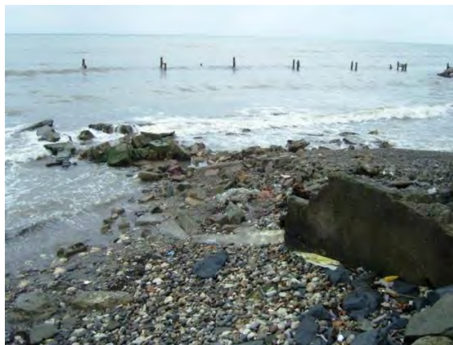
شکل ۱۴. پیش‌آمدگی آب دریا و تخریب بناهای مسکونی بتنی در ساحل چالوس (عکس از: قمری فتیده؛ ۱۳۹۲)
