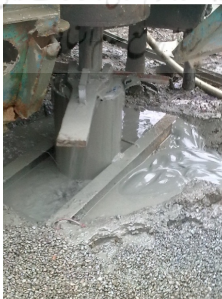
شکل ۳. شست‌وشو و تمیز کردن چاه
