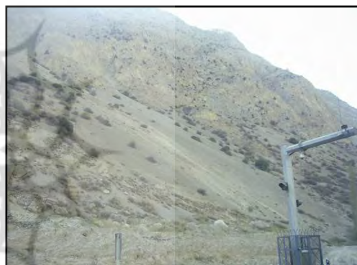
شکل ۶: مخروط واریزه‌ای شماره ۵ در کنار راه ارتباطی هراز
