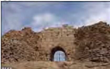
تصویر شماره ۱۵: تخت سلیمان آذربایجان غربی ظهور پوشش‌های طاقی در دهانه‌های بزرگ و گنبدها در مقطع چهارگوش.
