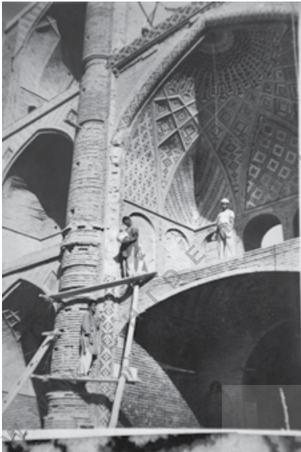
بازسازی تکیه امیرچخماق یزد، ۱۳۳۹، استادعلی اکبررحمانی خرمشاهی
