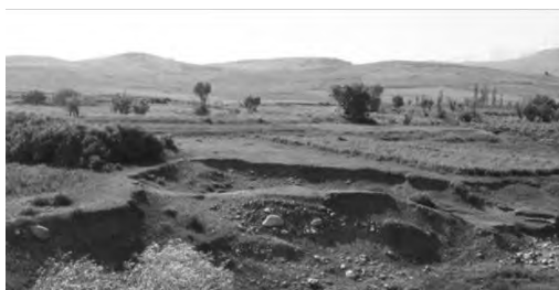
حرکت خاک در کینی جالی در فاصله‌ی حدود ۲۰۰ متری از جنوب منطقه‌ی مسکونی
