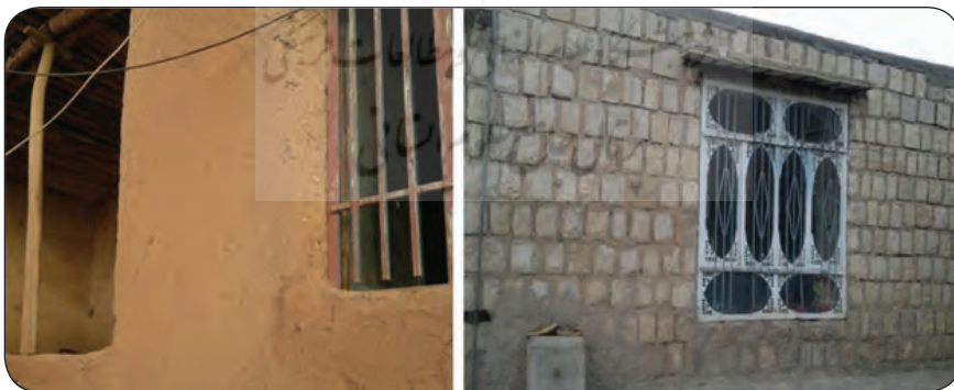
تصویر شماره (۴): استفاده از سنگ و کاه گل در بناهای مسکونی روستای هلسم (نگارندگان، ۱۳۹۳)
