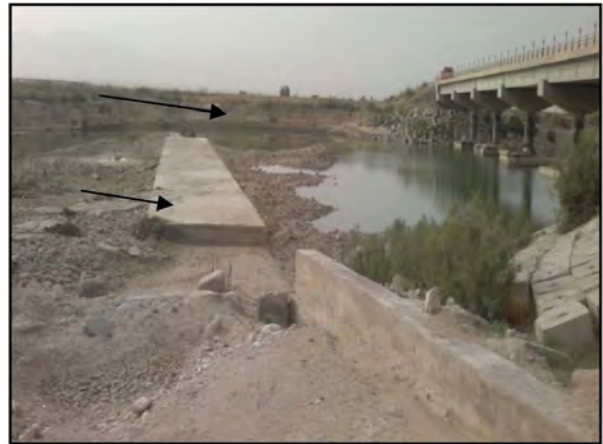
نگاره ۱۰: ساخت سکویی در بستر رود مند ۱۳۹۳ (نگاه از شمال)
