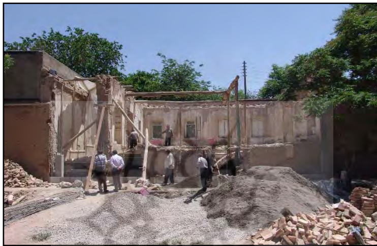
تصویر ۹. مقاوم‌سازی جبهه شرقی خانه صدقیانی با سازه اسکلت بتنی
