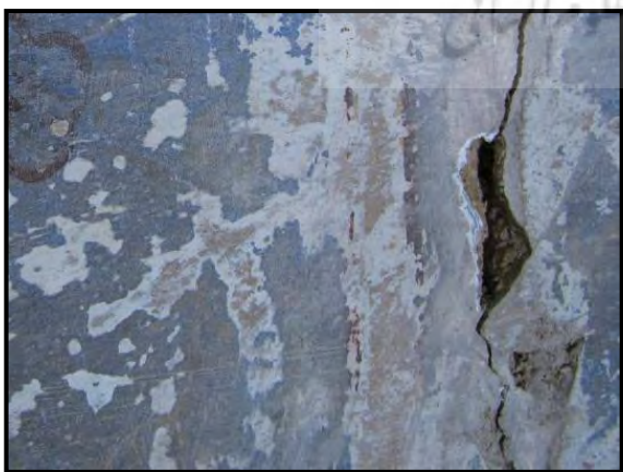
شکل ۴. اجرای کاهگل به‌عنوان لایه آستر
