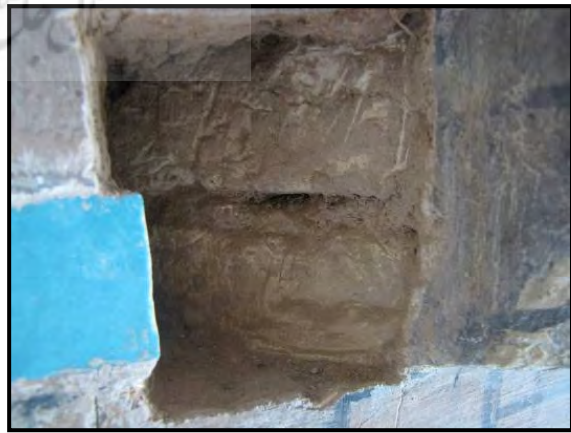
شکل ۳. تکیه‌گاه آجری با ملات کاهگل
