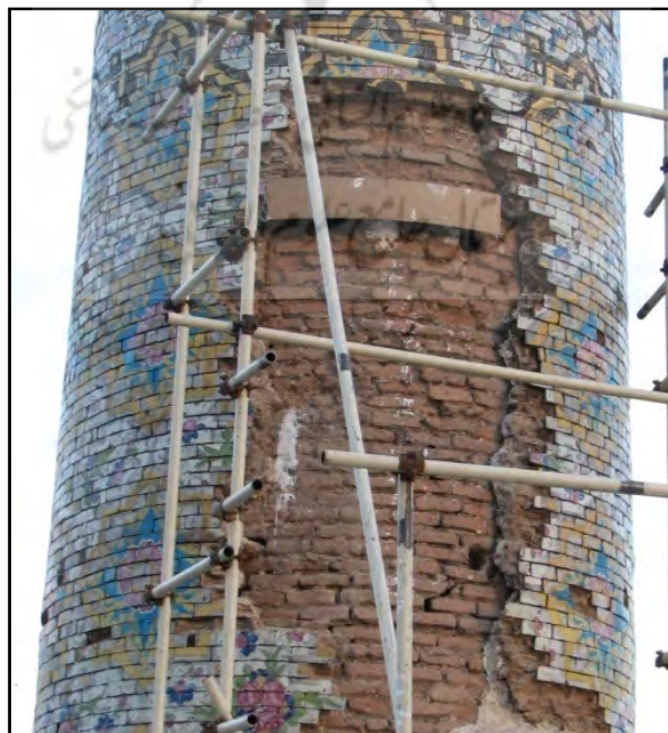
شکل ۸. نصب قالب چوبی هماهنگ با قوس بیرونی مناره برای مستندنگاری یک به یک
