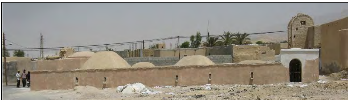
تصویر ۲۱. نمای شرقی حمام پس از مرمت - خرداد ۱۳۸۸
