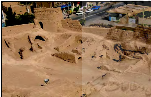
تصویر ۲۲. بخش بالایی جبهه شمالی و خشت‌های ابعاد ۱۰ \times ۲۴ \times ۴۰ . تصویر ۲۳. بخش پایینی جبهه شمالی (نگارنده).
