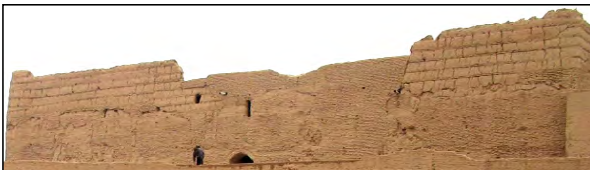
تصویر ۴. آثار مصطبه خشتی و ساخت و ساز دوره‌های مختلف در بدنه جنوبی ارگ (نگارنده، ۱۳۸۷)
