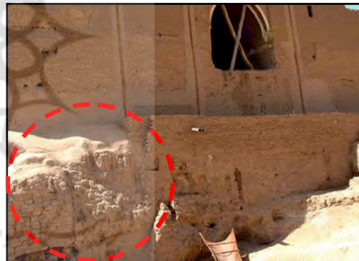
تصویر ۲۲. بخش بالایی جبهه شمالی و خشت‌های ابعاد ۱۰ \times ۲۴ \times ۴۰ . تصویر ۲۳. بخش پایینی جبهه شمالی (نگارنده).
