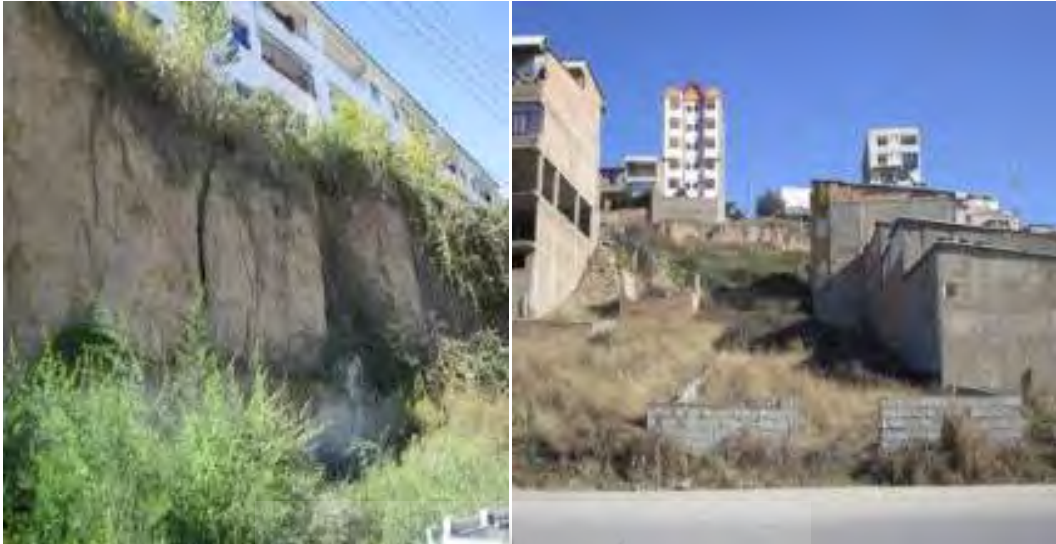
شکل ۹: احداث ابنیه بر روی بستر نامناسب لسی (عکس از نگارندگان)
