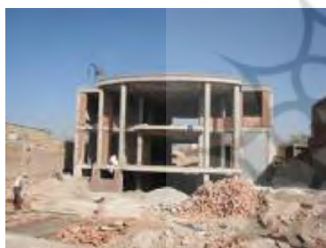
شکل (۸) نمایی از ساختمان‌های بتنی (واحد ۶)
