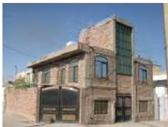
شکل (۶) نمایی از ساختمان‌های آجری شناژدار (واحد ۴)
