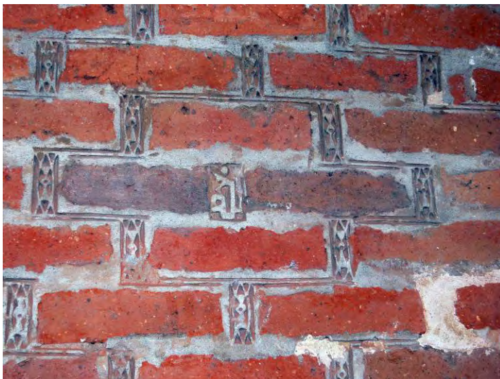
تصویر شماره ۷- کلمه الله به خط کوفی تزئینی در میان بندکشی آجری (عکس از نگارنده)
