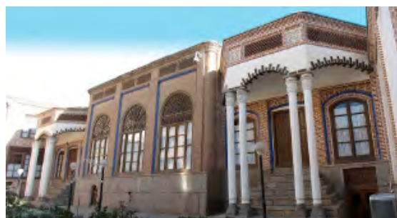
تصویر ۷: نمایی از ضلع شرقی حیاط بیرونی خانه سلماسی
