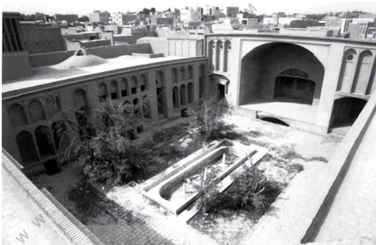
تصویر شماره ۱: جبهه‌های جنوب غربی و جنوب شرقی خانه مظفری، عکس از کیوان جوراچی.
