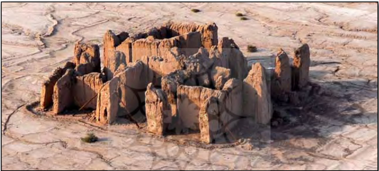
تصویر ۱ ب. نمایی از کوشک رحیم آباد، دید از جنوب شرق. مأخذ: پایگاه میراث جهانی بم.
