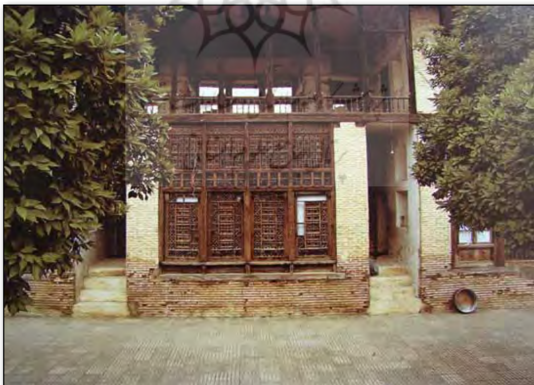
تصویر ۴. فضاهای نیمه بسته در قالب ایوان و گذرگاه. مأخذ: وزارت راه و شهرسازی، ۱۳۷۲.
